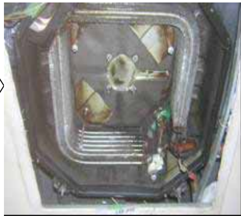
室内機の洗浄後
